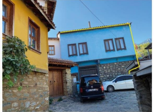
Pencerelerde geleneksel dokuya uymayan demir korkuluk uygulaması ve uyumsuz taş kaplamalar
