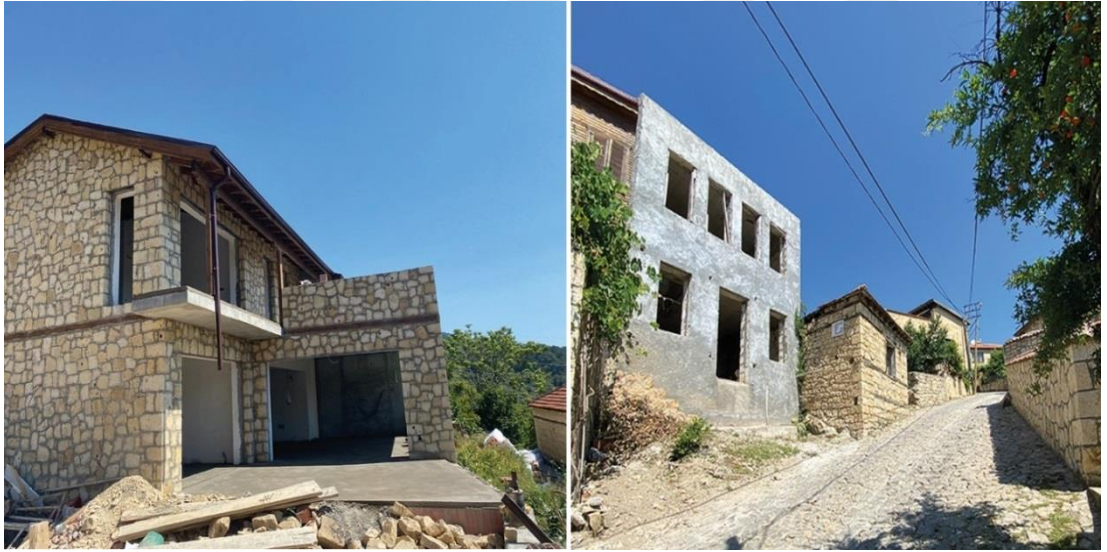
Şekil 3.6. Solda Artan Yeni Yapılaşmalar ve Sağda Doku ile Uyumsuz Yapılar (Yazar Arşivi)
