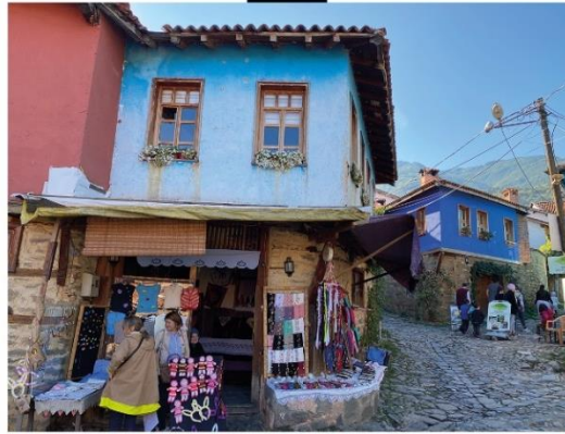
Zemin katlarda moloz taş malzeme, ahşap çıkma ve ahşap hatıllı kapı kullanımı
