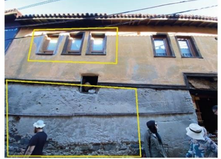
Taş malzemenin üzerine sıva uygulaması
