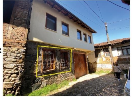
Pencerelerde geleneksel dokuya uymayan demir korkuluk uygulaması ve uyumsuz taş kaplamalar
