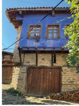
Zemin katlarda moloz taş malzeme, ahşap çıkma ve ahşap hatıllı kapı kullanımı
