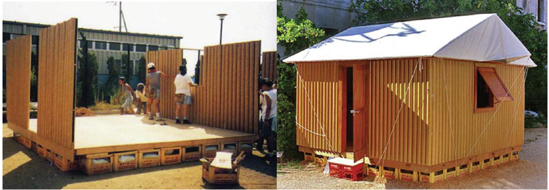
Şekil 4.15. (üst) Paper Log House kurulum aşaması ve (alt) dış mekan görünümü (Url-11).
