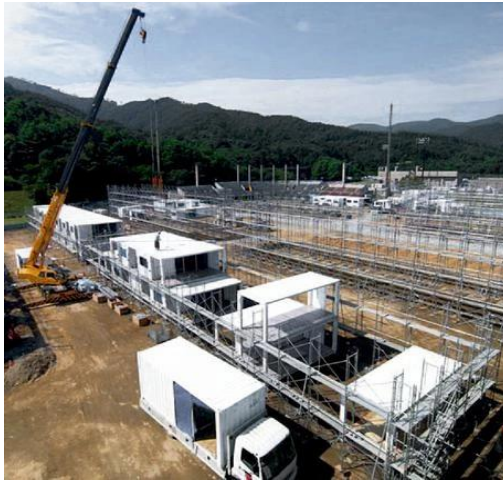
Şekil 4.20. Birimlerin kurulum aşaması ve dış mekan görünümü (Url-13).
