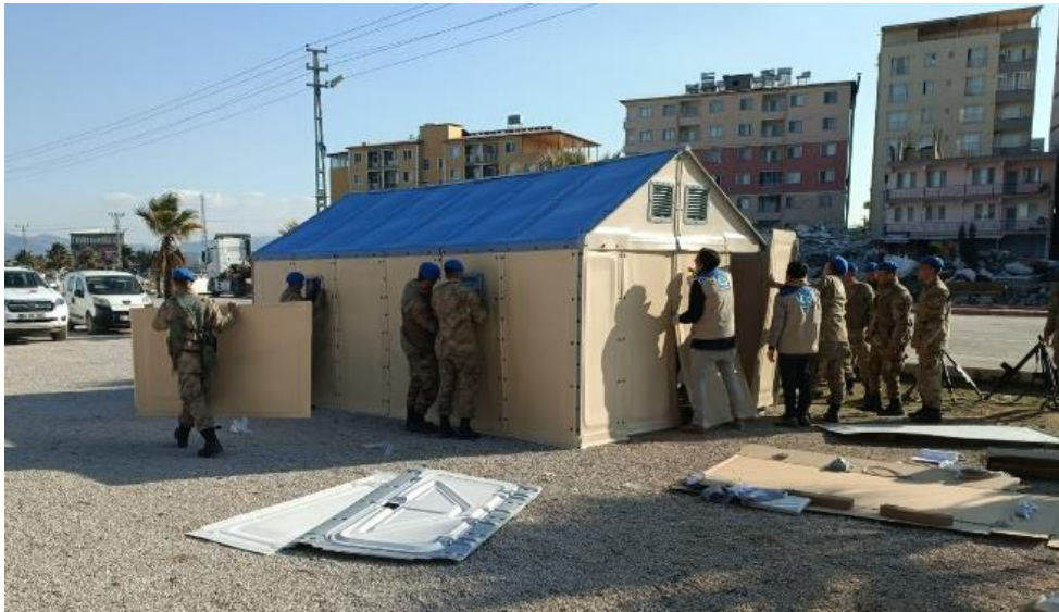
Şekil 4.17. Hatay'daki afetzedelere gönderilen Better Shelter kurulum aşaması (Url-12).
