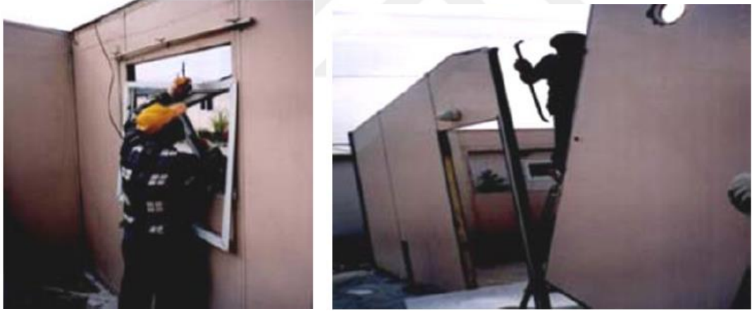
Şekil 3.1. Düzce depreminde kullanılan geçici birimlerim söküm işlemleri (Coşgun ve Arslan, 2007).
