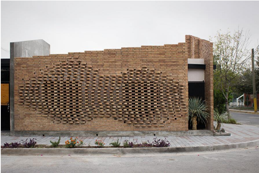
Görsel 29: Meksika'nın Monterrey kentinde bulunan bir ev Papagayo, ekleme yöntemli parametrik tasarım uygulaması – Arkitekt gazete.com (yapım yılı: 2018)
