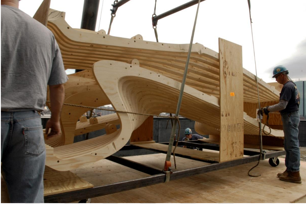
Görsel 238: dECOi Architects tarafından gerçekleştirilmiş olan One Main Office'in montaj aşaması
