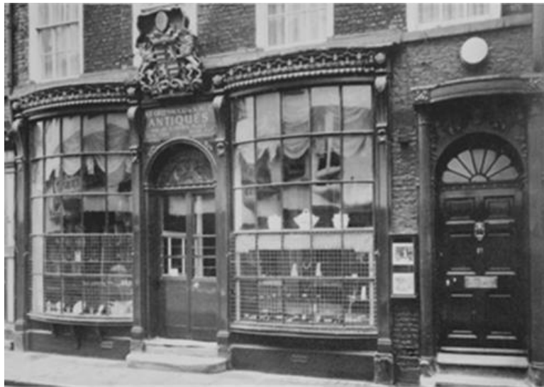
Şekil 2.10 : 19. yüzyıl başlarında mağaza cephesi, Stonegate (URL 10)
