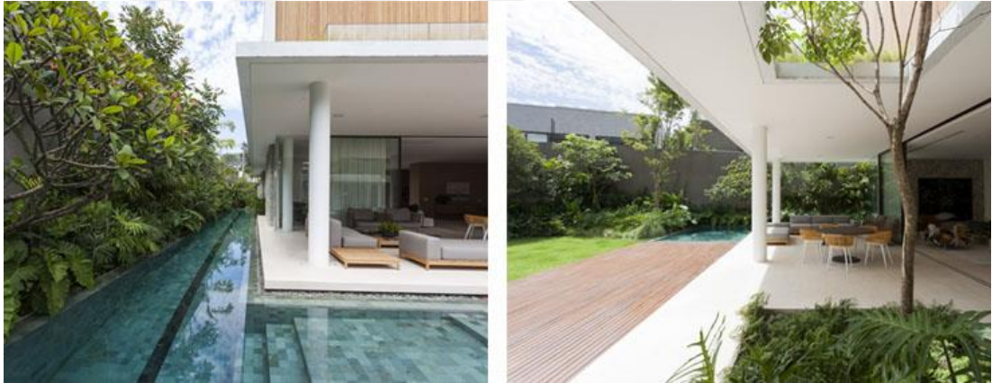
Şekil 5.11 Flamengo House (URL-33) (URL-34)
