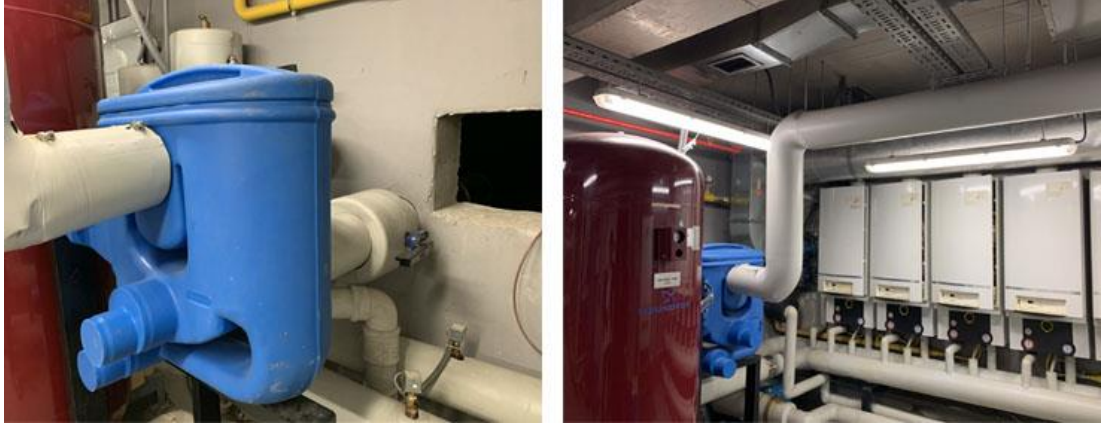
Şekil 5.71 Yağmur Suyu Toplanıp Filtreden Geçmekte (Araştıran tarafından çekilmiştir)
