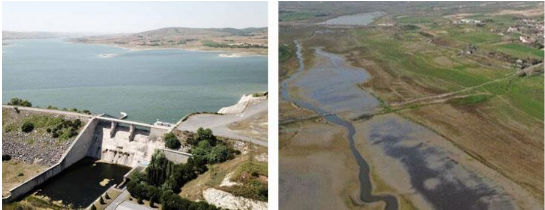
Şekil 3.6 Kurumakta olan Sazlıdere Barajı (URL-5) (URL-6)
