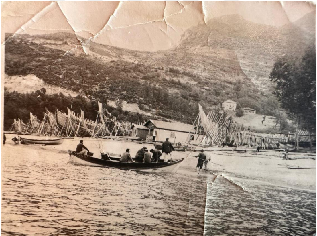
Ek 8. Kapısuyu'nda yapılan çekirmeler
