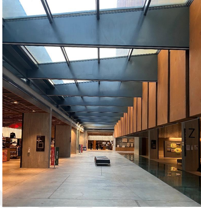
Şekil 5.16: Troya Müzesi zemin kat tavan penceresi (Tuzcu, 2022)
