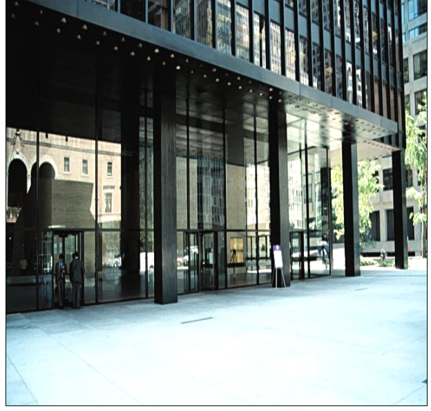
Şekil 2.2.11: Mies van der Rohe'nin tasarladığı Seagram Binası giriş cephesi, 1948-1951, Chicago(www.Greatbuildings.com)
