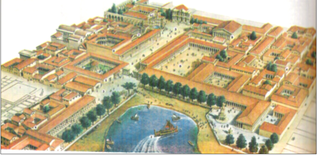
Resim: 2.2.1: Hippodamus'un eski yunan kenti Milet'in kuzey liman kesimi kent fotoğrafı, İÖ 475 (Larousse, 12638, 1986)
