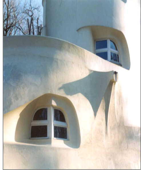
Resim 2.2.14: Einstein kulesi geometrik cephe boşluğu, 1921, Berlin (www.archpedia.com)
