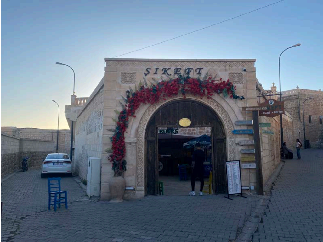
Şekil 40.Şikeft (otel,kafe) cepheden görünüm
