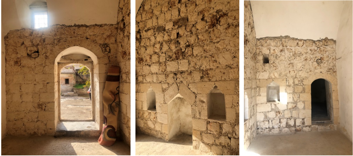
Şekil 60. Zemin kat onarım öncesi (R. DAŞ; Arşiv,2025).
