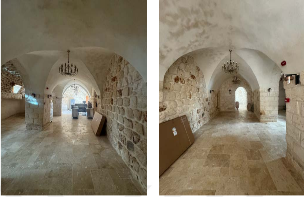
Şekil 111. Bodrum kat onarım sonrası (H. TUNÇ, 2025, Kişisel Arşiv).
