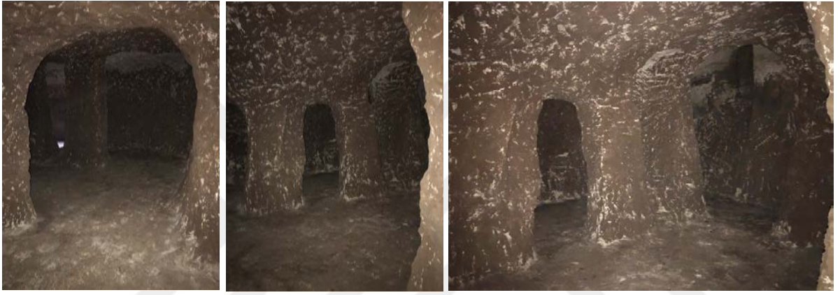
řekil 51. Bodrum kat onarım ncesi
