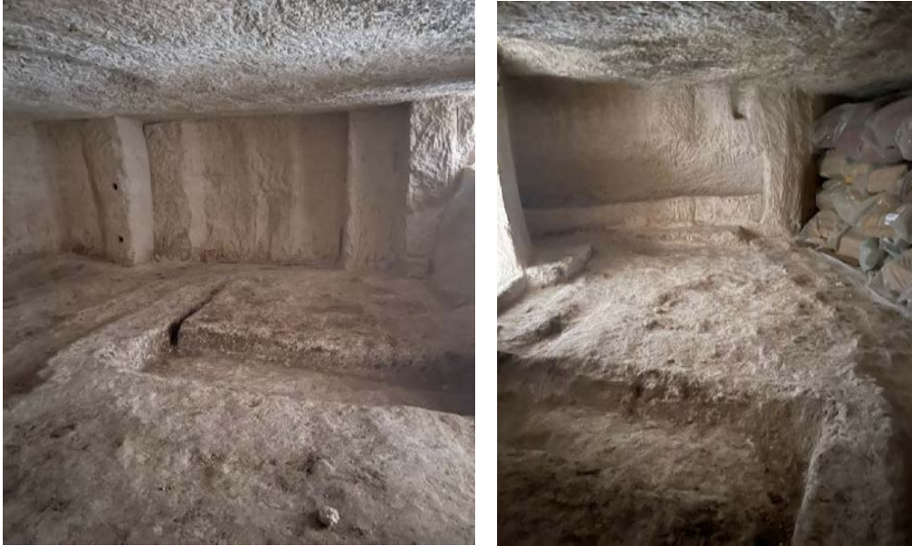
řekil 44. Bodrum kat onarım sonrası
