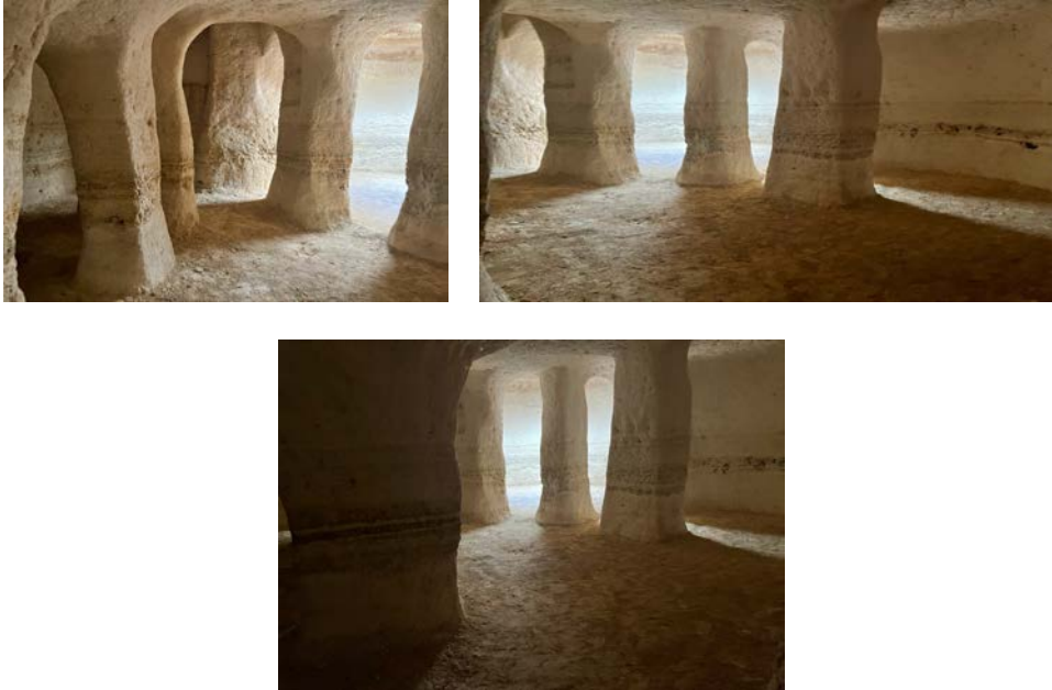
řekil 52. Bodrum kat onarım sonrası
