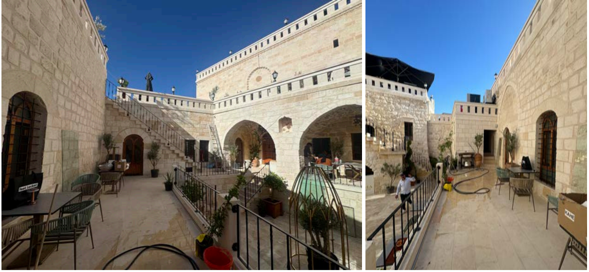
Şekil 153. Zemin kat onarım sonrası (H. TUNÇ, 2025, Kişisel Arşiv).
