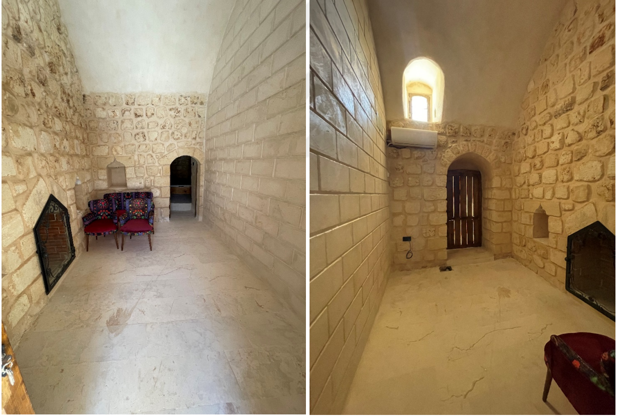
Şekil 61. Zemin kat onarım sonrası (H. TUNÇ, 2025, Kişisel Arşiv).
