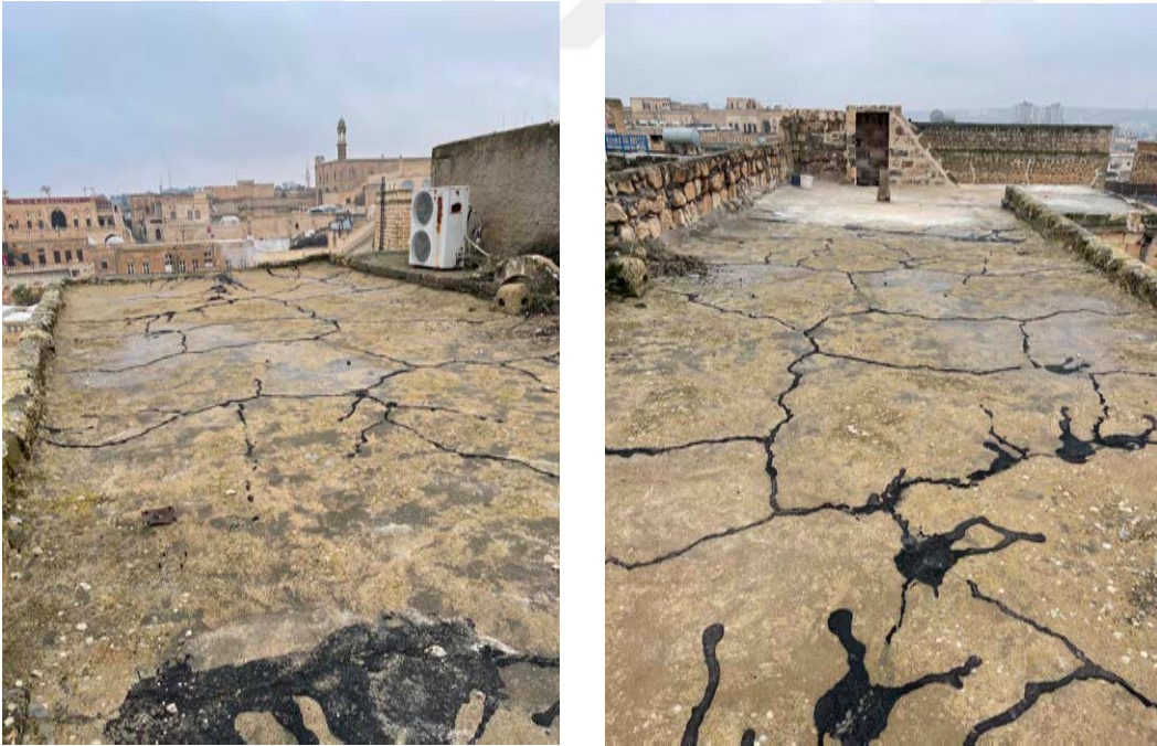
Şekil 178. Dam-1 onarım öncesi
