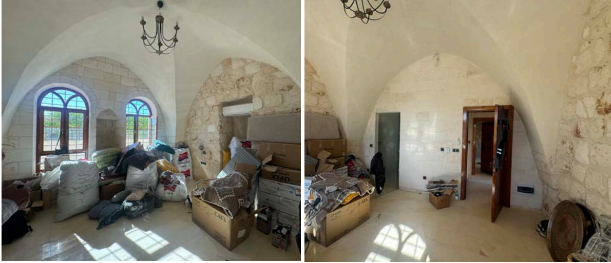
Şekil 129. Zemin kat onarım sonrası (H. TUNÇ, 2025, Kişisel Arşiv,2025).
