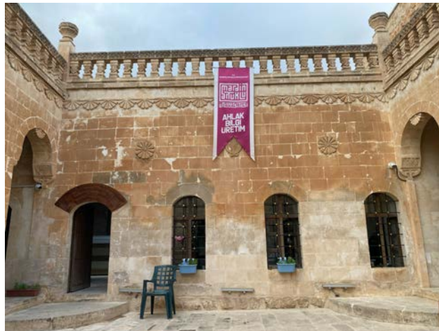
Şekil 226. Mardin artuklu üniversitesi gümüş telkari uygulama atolyesi cephe görünümü.
