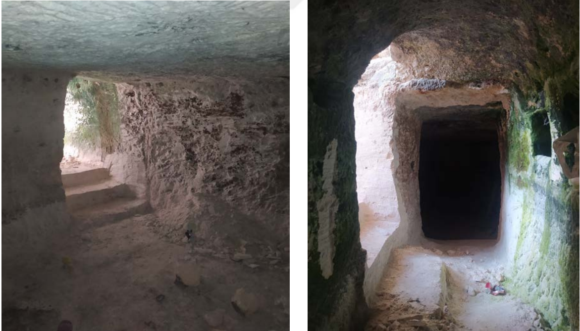
Şekil 214. Bodrum kat restorasyon öncesi. (M. M. AKSOY, Arşiv, 2025).
