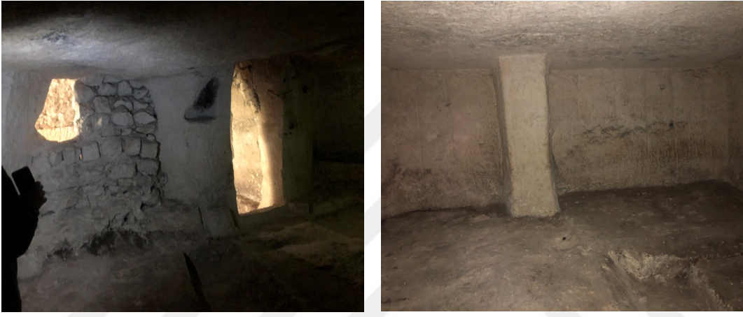
řekil 43. Bodrum kat onarım ncesi
