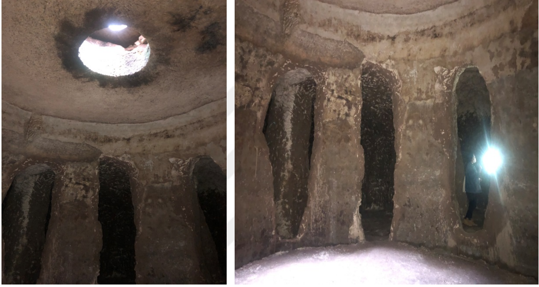
řekil 55. Bodrum kat onarım ncesi
