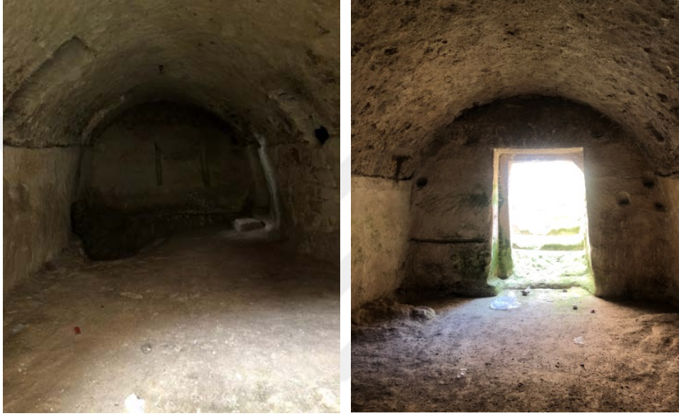
řekil 47. Bodrum kat onarım ncesi
