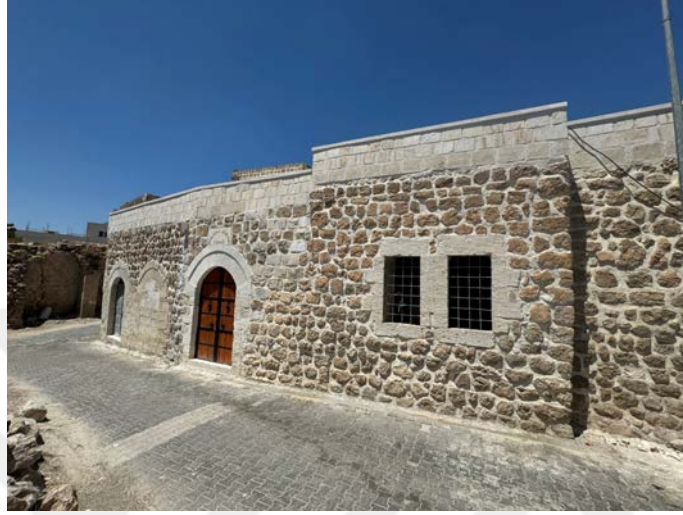
Şekil 184. Sincar konağı (otel) cepheden görünüm
