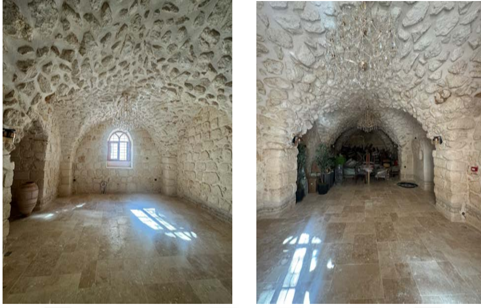
Şekil 117. Bodrum kat onarım sonrası
