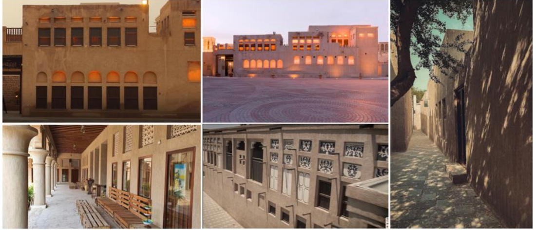
Şekil 38: Shiekh Saeed Konutunun görsellik dengesi.
