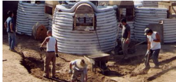
Şekil 4.11. Kum Torbasından Yapılan Acil Durum Geçici Barınma Üniteleri (URL-21).
