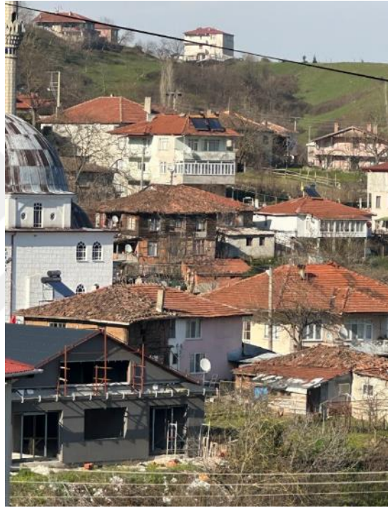
Şekil 5.8. Hasaneyn Köyü'nde Çatılardaki Güneş Paneli Kullanımına Dair Fotoğraf (Yazar tarafından çekilmiştir).
