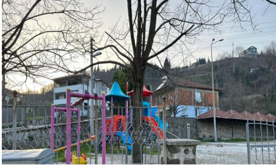
Şekil 5.11. Hasaneyn Köyü’ndeki Yıkılan Okulun Bahçesinin Mevcut Durumu (Yazar tarafından çekilmiştir).
