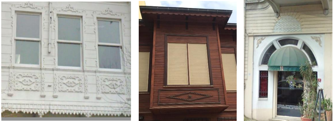
Görsel 5.32: 3, 15 ve 1 No'lu Yapılarda Yer Alan Pencere Altı Panolar (G.A)
