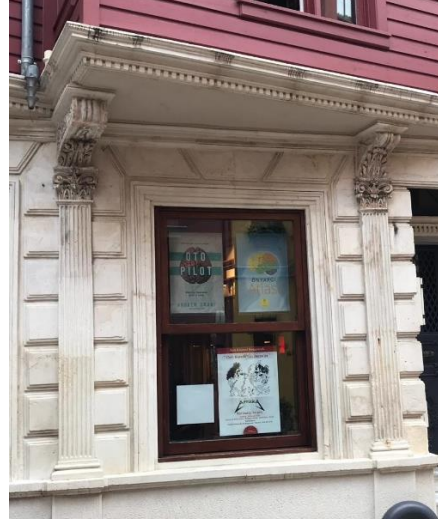
Görsel 5.27: 12 No'lu Yapı Girişi ve Çıkmaya Destek Sağlayan Konsollar Etrafındaki Sütunceler (G.A)
