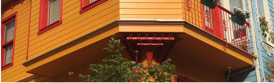
Görsel 5.17: Köşe Çıkma Konsolun Diyagonal Yerleşimi (G.A)
