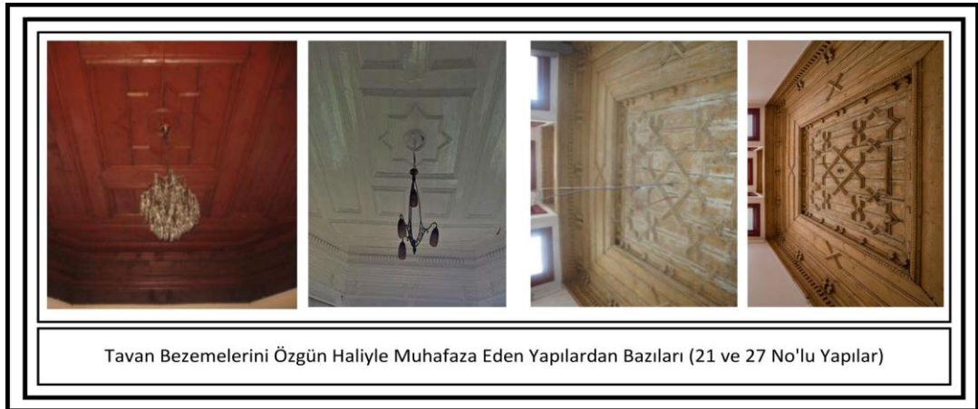
Görsel 6.23: Özgün Durumunu Koruyan 21 ve 27 No'lu Yapıların Tavan Bezemeleri (G.A.)
