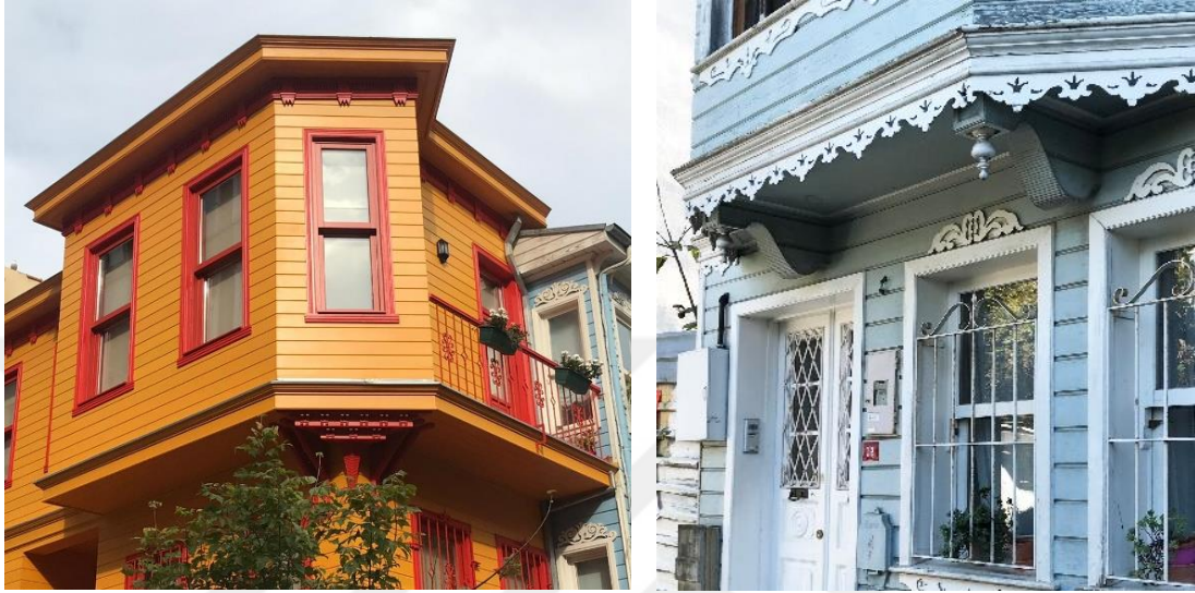
Görsel 5.23: Kat ve Saçak Silmesinin Bir Arada Görüldüğü 14 ve 21 No'lu Yapılarda Saçak Profili(G.A)
