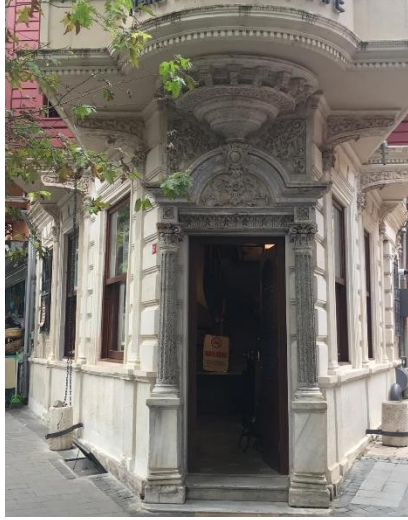
Görsel 5.27: 12 No'lu Yapı Girişi ve Çıkmaya Destek Sağlayan Konsollar Etrafındaki Sütunceler (G.A)
