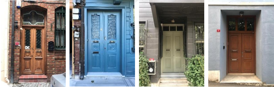
Görsel 5.10: Nişli Girişli Yapı Örnekleri (4 No'lu, 21 No'lu, 25 No'lu ve 26 No'lu Yapılar)((G.A)
