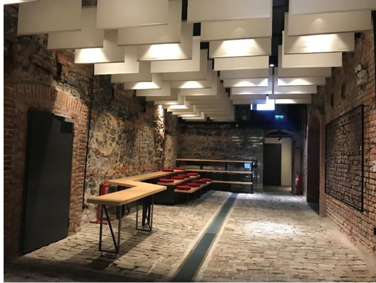
Şekil 6.35 : Bomontiada Akustik Paneller ile Yaratılan Söyleşi Mekanı
