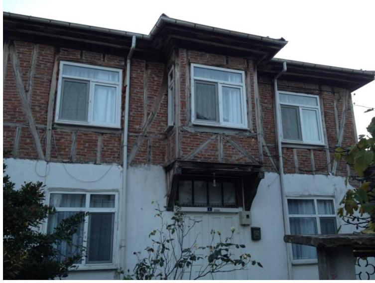
Şekil 3. 20 : Niteliksiz Ekler ve Müdahaleler Görmüş Geleneksel Özellikler Taşıyan Bir Yapı, Fevzipaşa Sokak No: 8 (Kara, 2013)
