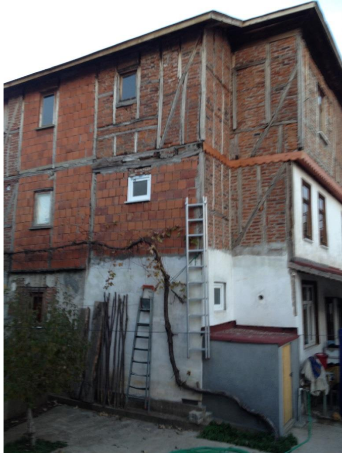
Şekil 3. 19 : Niteliksiz Ekler ve Müdahaleler Görmüş Geleneksel Özellikler Taşıyan Yapı, Fevzipaşa Sokak No: 10 (Kara, 2013)
