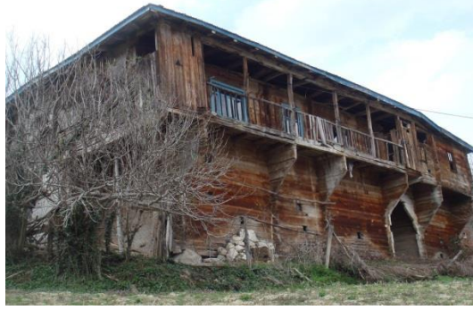
Şekil 2. 3: Ahşap Yığma Yapı Örneği, Gökçebey, Zonguldak (gevezemimar.blogspot.co.uk, 2014)
