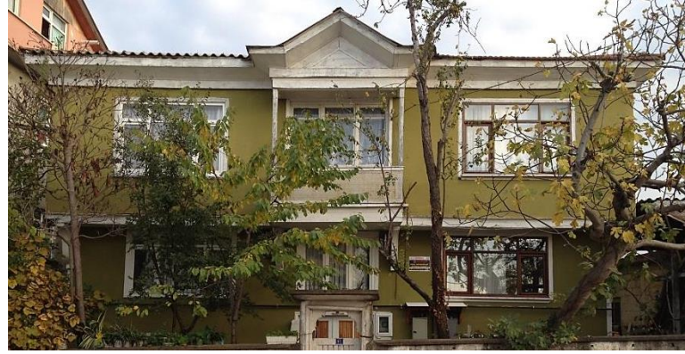
Şekil 3. 8: Kaplamalı Payandalı Sürekli Çıkma, Cumhuriyet Caddesi No:11 (Kara, 2013)
