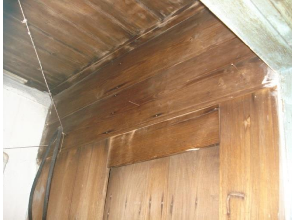
Şekil 4. 59 : Z/06 Mekanı Ahşap Tavan (Kara, 2013)
