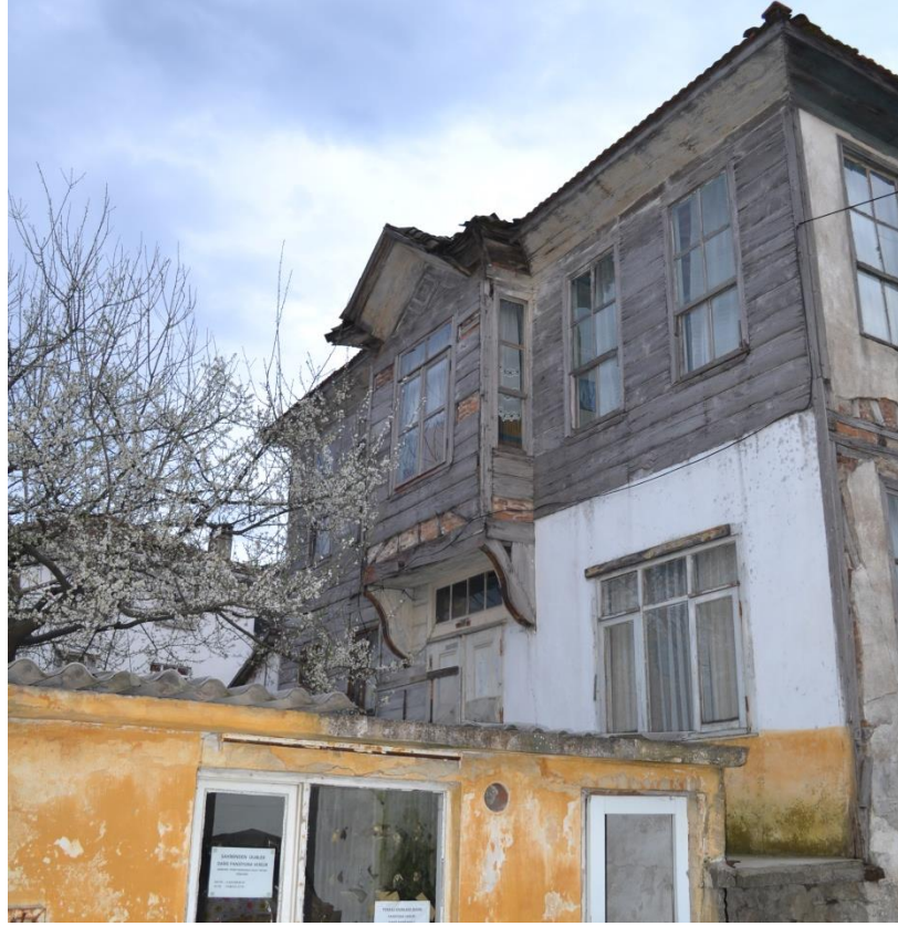
Şekil 4. 83 : Kuzey Cephedeki Ahşap Kaplama ve Çimento Sıvalı Kısım (Kara, 2013)
