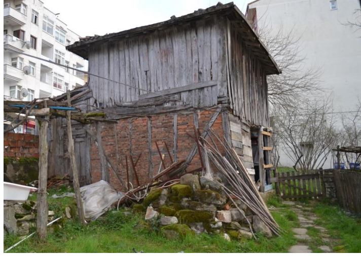
Şekil 4. 77 : Tamın Özgün Kısımının Kuzey Cephesi (Kara, 2013)
