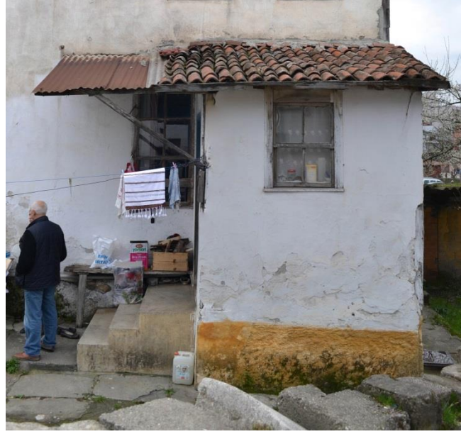
Şekil 4. 88 : Z/07 Mekanının Doğu Cephesi (Kara, 2013)
