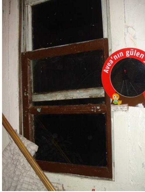
Şekil 4. 57 : Z/06 Mekanı Giyotin Pencere (Kara, 2013)
