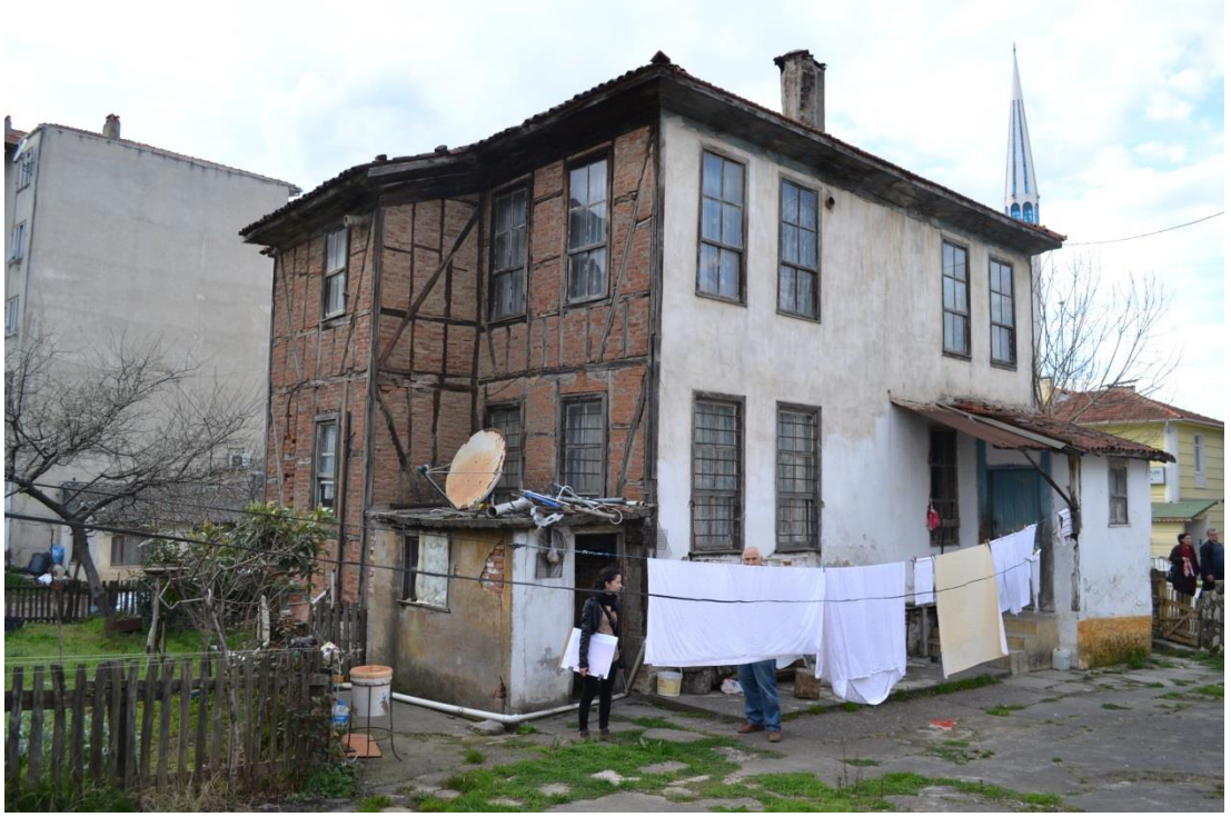
Şekil 4. 7 : Güney Batı Cephesi (Kara, 2013)
