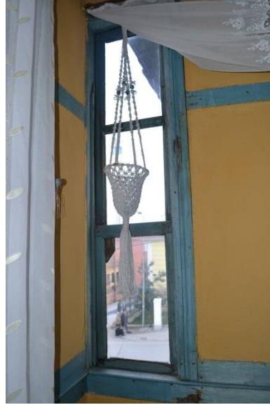
Şekil 4. 62 : B1/01 Mekanı Batı Çıkması Dar Giyotin Penceresi (Kara, 2013)
