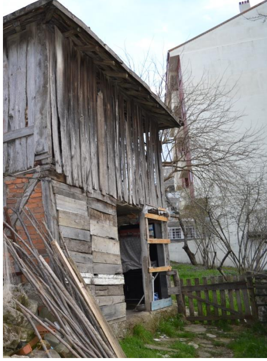
Şekil 4. 95 : Tamın Özgün Kütlesinin Batı Cephesinden Girişi (Kara, 2013)
