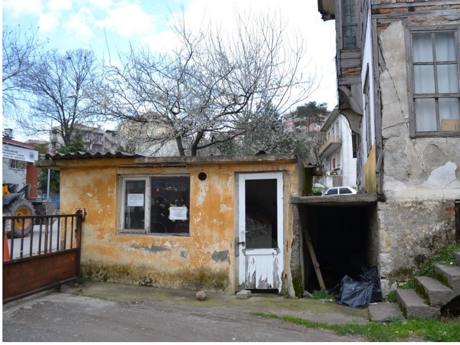
řekil 4. 13 : Otopark Kontrol Kulübesi (Kara, 2013)
