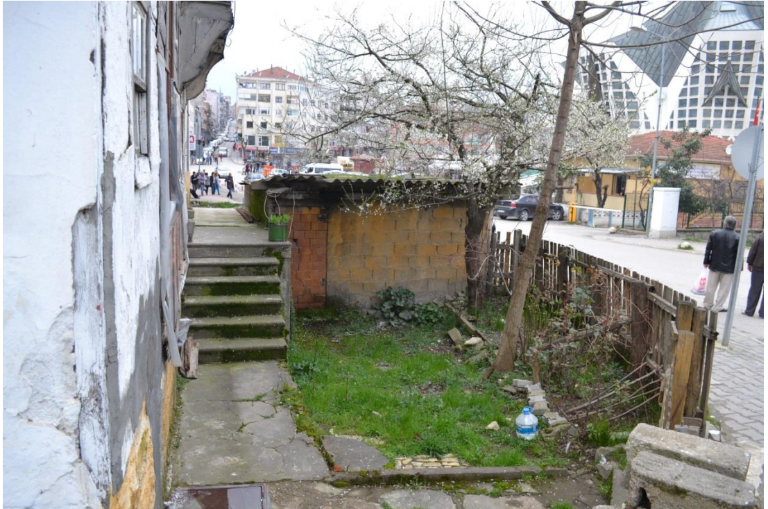
Şekil 4. 12 : Yapı Ana Giriş Kapısı Önü Beton Merdivenler ve Bahçe (Kara, 2013)
