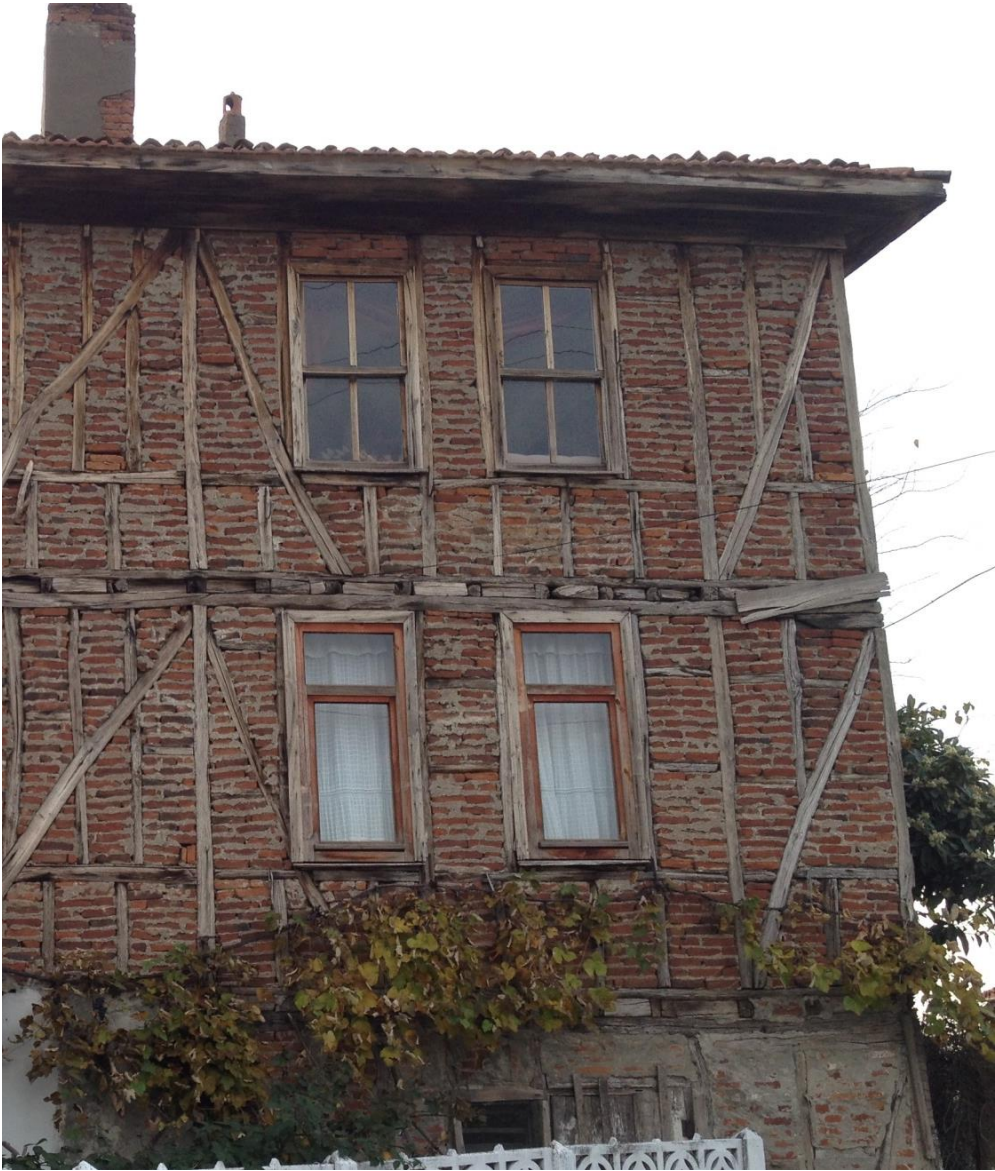
Şekil 3. 10: Ahşap Karkas Sistem Örneği, Baki Çelebi Sok, No: 16 (Kara, 2013)
