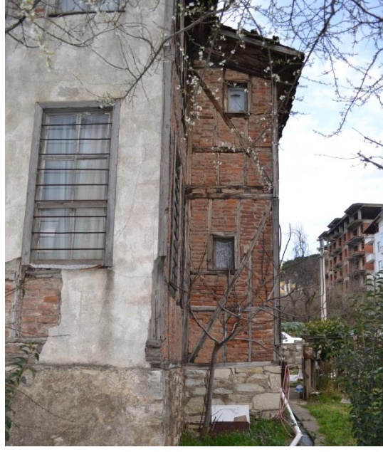
Şekil 4. 91 : Tuvaletlerin Batı Cephesi (Kara, 2013)
