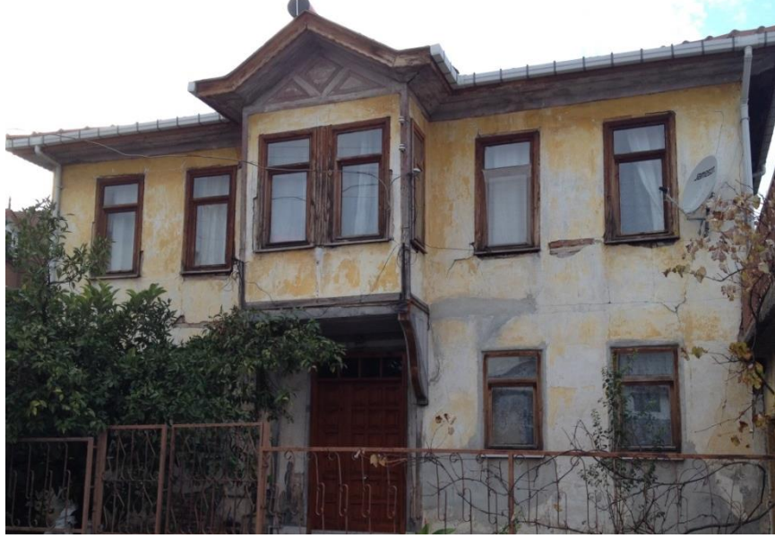
Şekil 3. 13: Kaplamalı Payandalı Çıkma Örneği, Park Caddesi, No: 28 (Kara, 2013)
