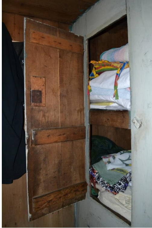
Şekil 4. 49 : Kapı Tarafındaki Dolap ve Ahşap Kapağı (Kara, 2013 )
