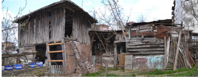
Şekil 4. 94 : Tamın ve Ek Yapıların Batı Cephesi (Kara, 2013)
