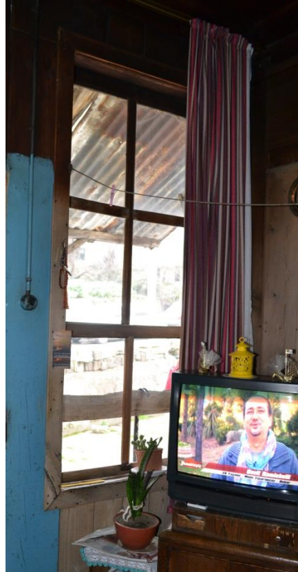
Şekil 4. 43 : Doğu Duvarındaki Pencere (Kara, 2013)
