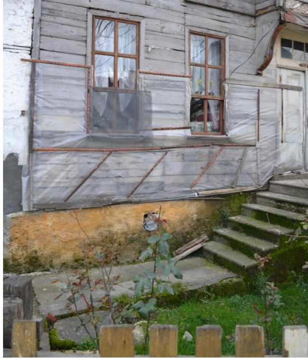
Şekil 4. 82 : Kuzey Cephe'deki Çimento Sıvalı Bodrum Duvarları ve Beton Merdiven ile Sahanlık (Kara, 2013)
