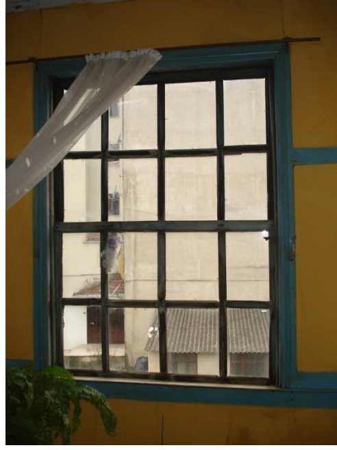
Şekil 4. 61 : B1/01 Mekanı Batı Çıkması Geniş Giyotin Penceresi (Kara, 2013)
