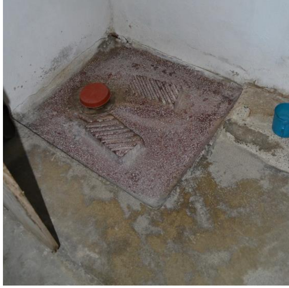
Şekil 4. 73 : B1/06 Mekanındaki Dökme Mozaik Tuvalet Taşı (Kara, 2013)
