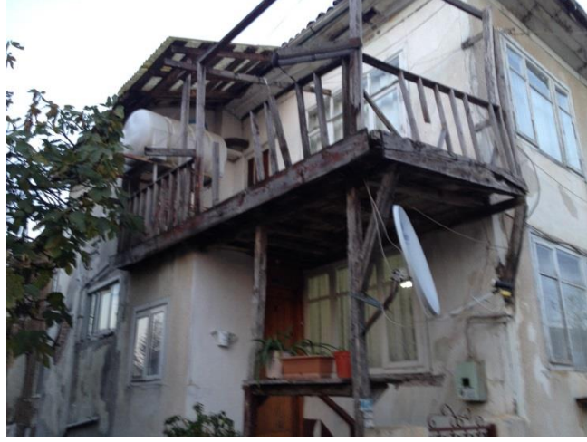
Şekil 3. 12: Ahşap Çardak Örneği, Ertuna Sokak, No:9 (Kara, 2013)
