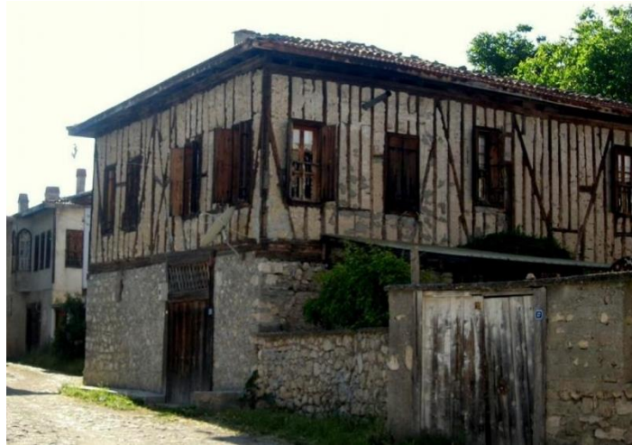
Şekil 2. 5: Karma Sistem İle Yapılmış Bir Yapı, Safranbolu Yörük Köyü (gezente.com)
