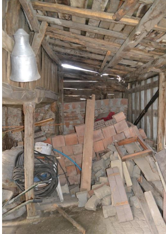
Şekil 4. 80 : Tamın Zemin Katta Sonradan Eklenen Kısım (Kara, 2013)
