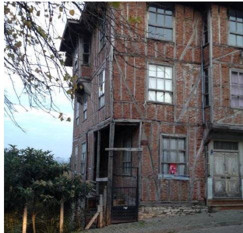
Şekil 3. 9: Dikmeler Üzerine Oturan Çıkma, Talat Uğur Caddesi No: 1 (Kara, 2013)
