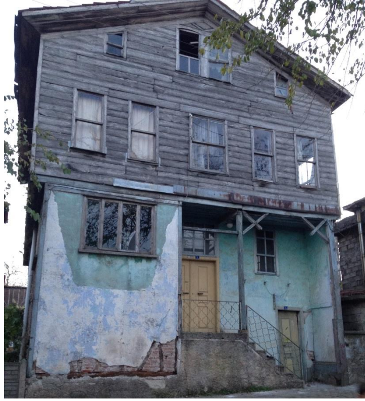
Şekil 3. 6: Dikmelerle Taşıtılan Çıkmalar, Talat Uğur Caddesi, No:1 (Kara, 2013)
