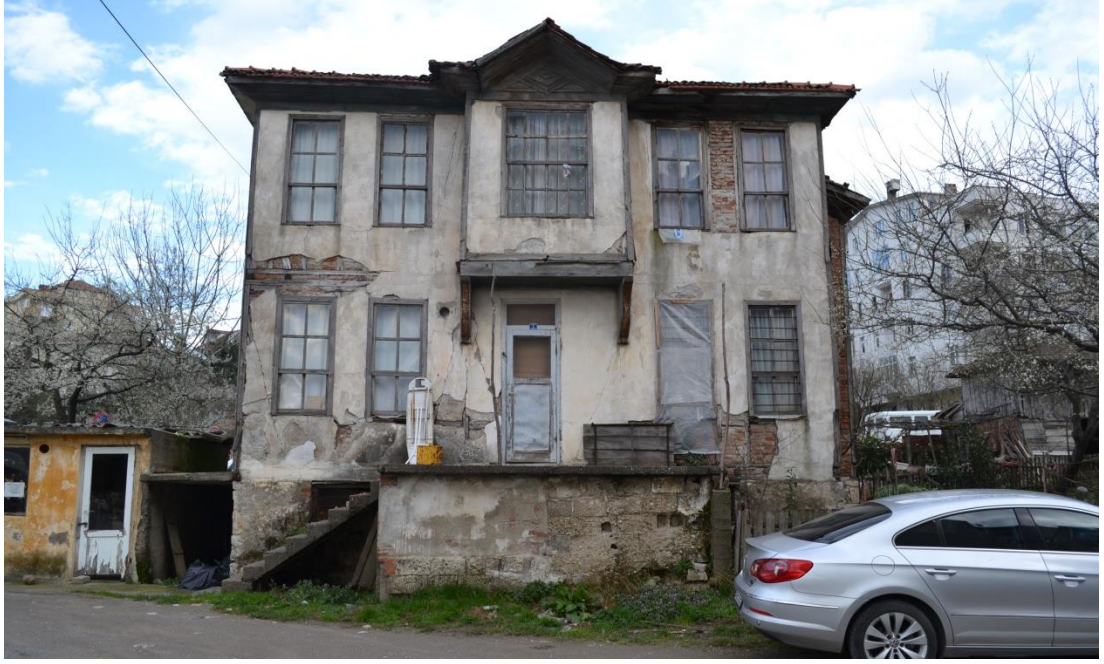
Şekil 4. 89 : Batı Cephesi (Kara, 2013)
