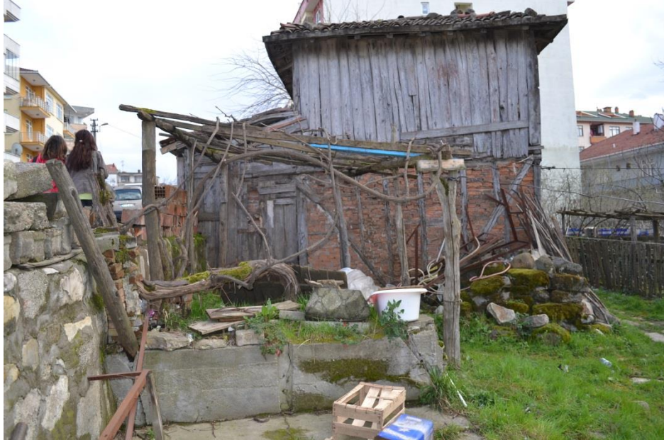
Şekil 4. 93 : Tamın Kuzey Cephesi (Kara, 2013)
