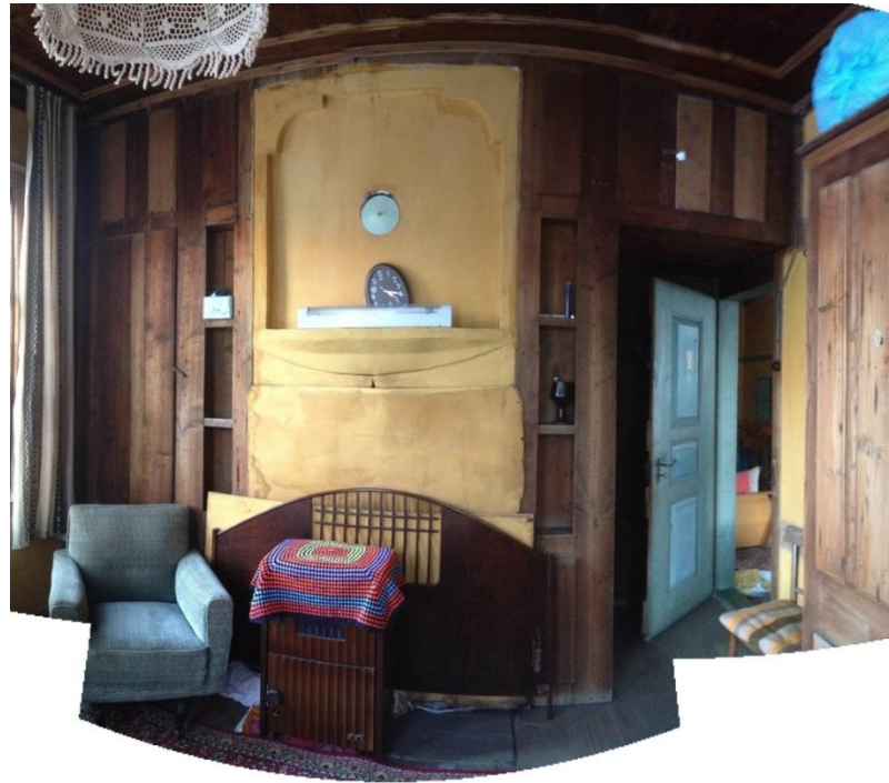
Şekil 4. 68 : B1/02 Mekanı Güney Duvarı (Kara, 2013)
