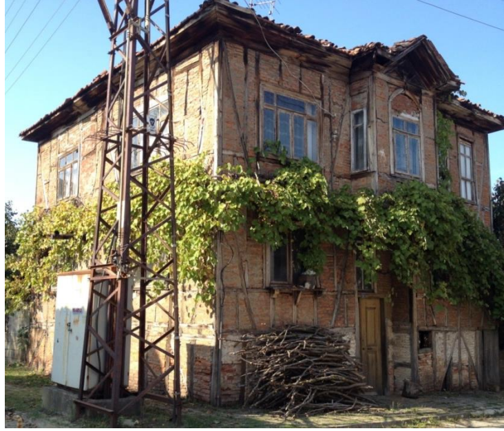
Şekil 3. 14: Üçgen Alınlık ve Çatı İle Birleşimi, Rifat Ilgaz Caddesi No: 25 (Kara, 2013)
