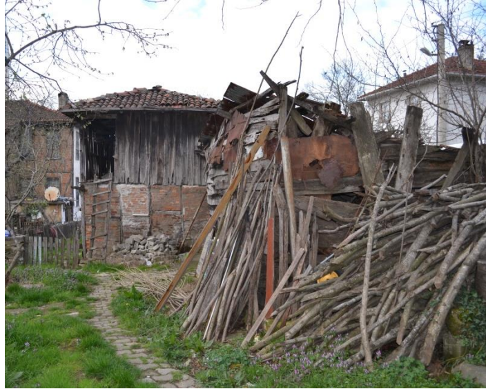
Şekil 4. 96 :Tamın Güney Cephesi (Kara, 2013)
