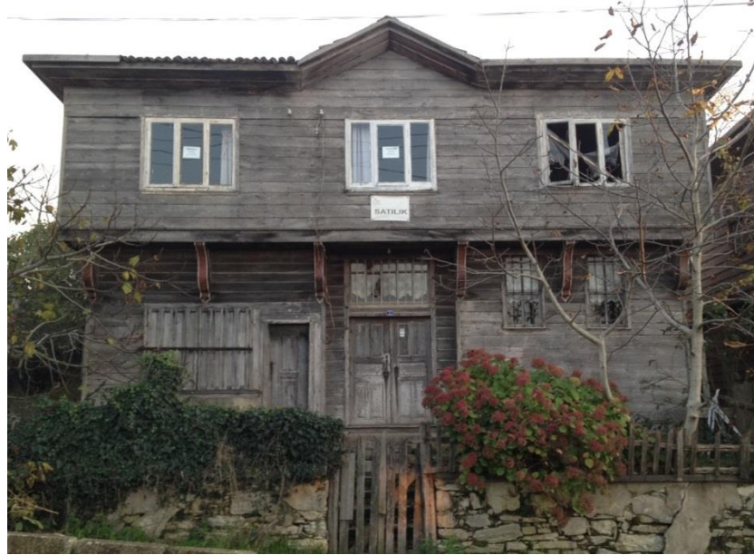
Şekil 3. 54: Cephe Boyunca Sürekli Kaplamalı Payandalı Çıkma Örneği, Tekke Sokak, No:5 (Kara, 2013)
