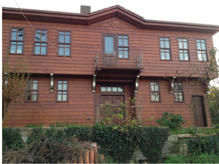
Şekil 3. 21: Restorasyonu Yapılmış Yapı, Tekke Sokak No: 7 (Kara, 2013)
