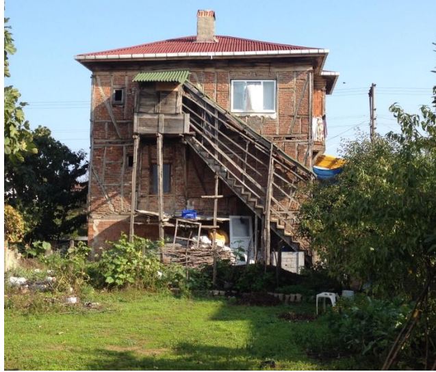
Şekil 3. 16: Cephe Boyunca Devam Eden Merdiven, Hacı Mehmet Sokak, No: 7 (Kara, 2013)
