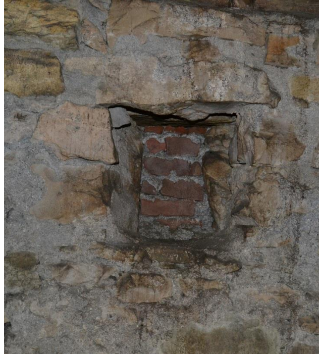
Şekil 4. 27 : Güney Havalandırma Deliğı (Kara, 2013)
