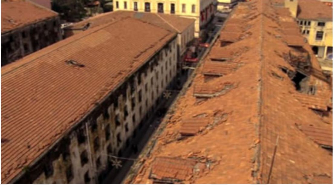
Şekil 5.8: Yeni İşlev Verilmeden Önce Fabrika Çatısı
