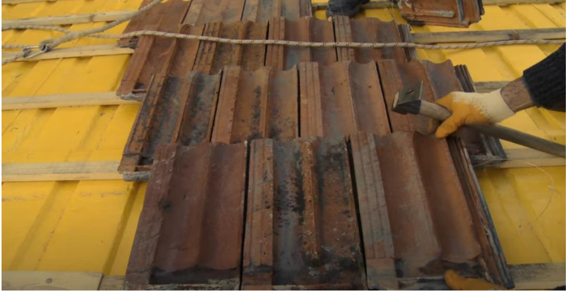
Ek.B6: Samsun Tütün Fabrikası Restorasyon Çalışması-Orijinal Alaturka Kiremitlerin Temizlenmesi (URL 37)
