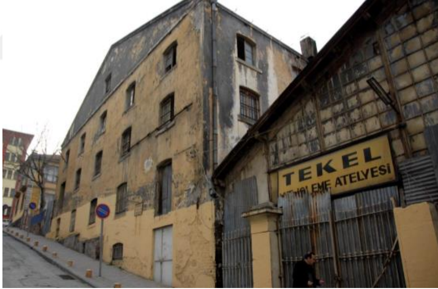
Şekil 5.9: Fabrika Girişi Ve Dış Duvarı
