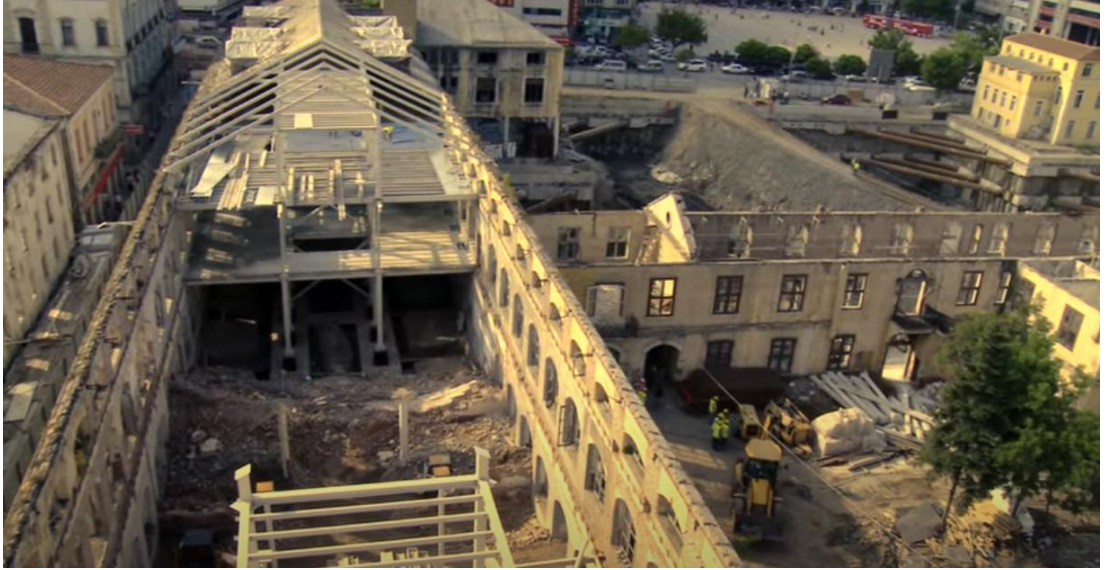
Ek.B8: Samsun Tütün Fabrikası Restorasyon Çalışması-Çatıların Sökülüp Çatı Taşıyıcısının Güçlendirilmesi (URL 37)
