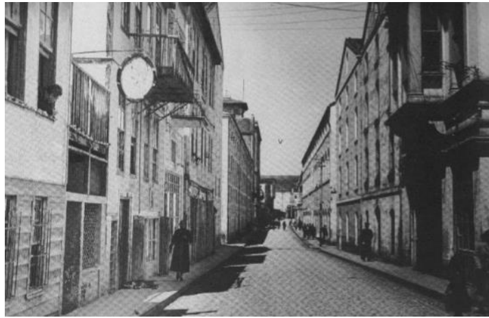
Şekil 5.5: Samsun Tütün Fabrikası Taş Binaları
