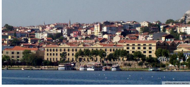
Şekil 3.19: Kadir Has Üniversitesi (Cibali Tütün Fabrikası Restorasyon sonrası)
