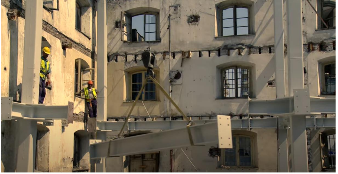
Ek.B5: Samsun Tütün Fabrikası Restorasyon Çalışması-Cephe İşçiliği (URL 37)
